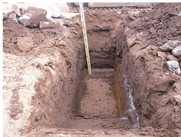
トレンチ写真2
