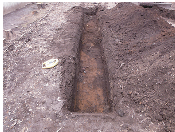
トレンチ写真2
