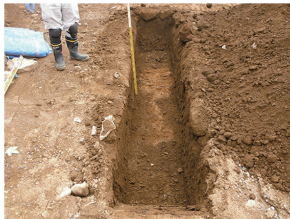
トレンチ写真
