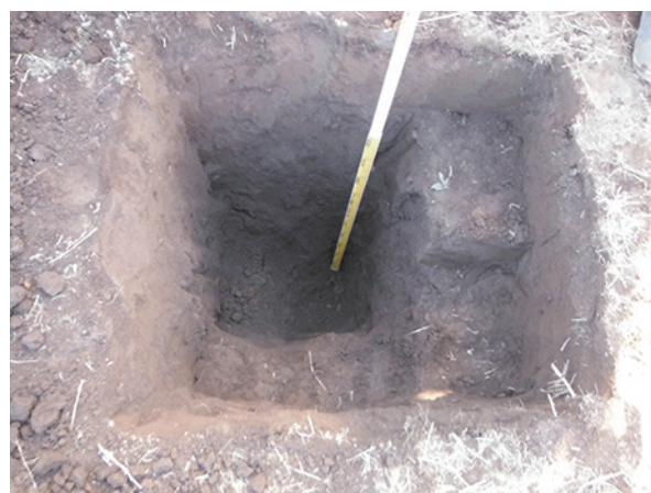
トレンチ写真
