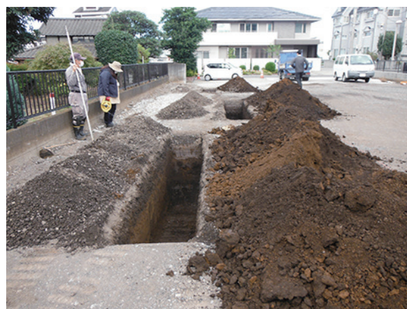
トレンチ写真2
