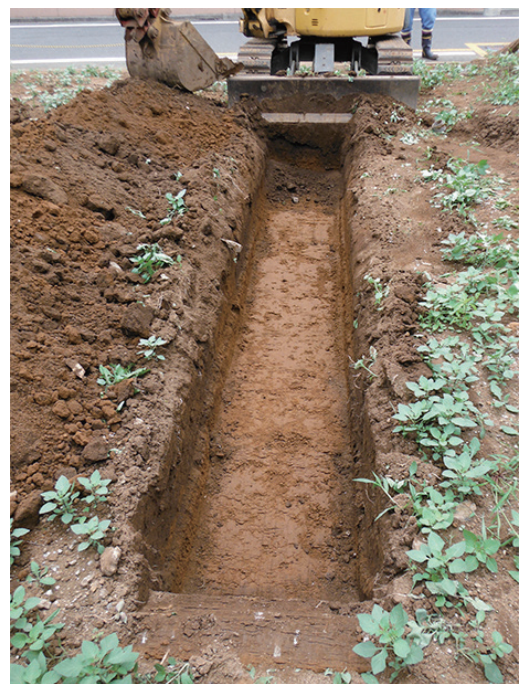
トレンチ写真2
