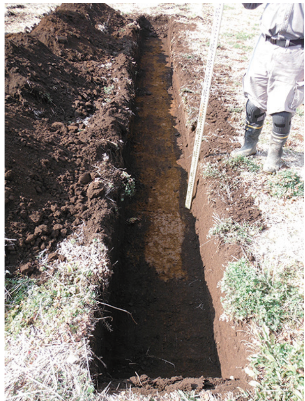
トレンチ写真
