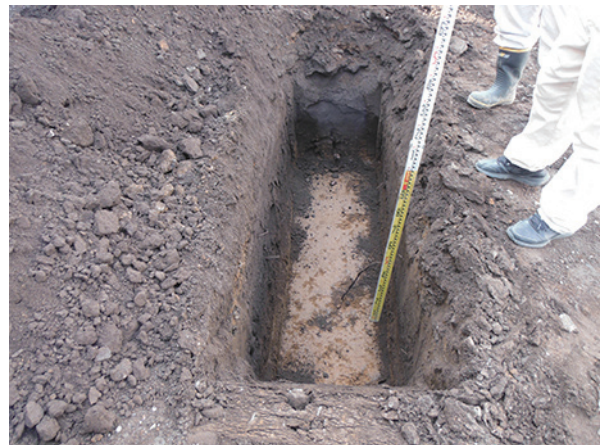
トレンチ写真2
