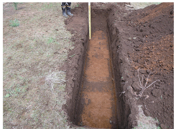
トレンチ写真
