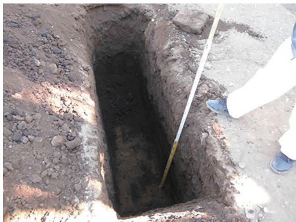
トレンチ写真
