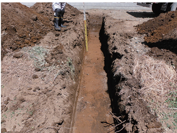
トレンチ写真1
