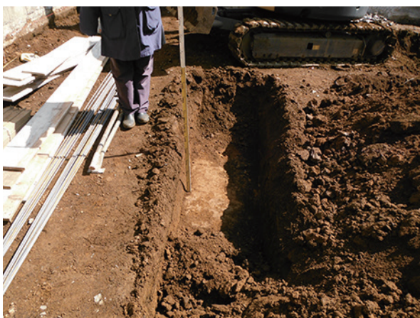
トレンチ写真1
