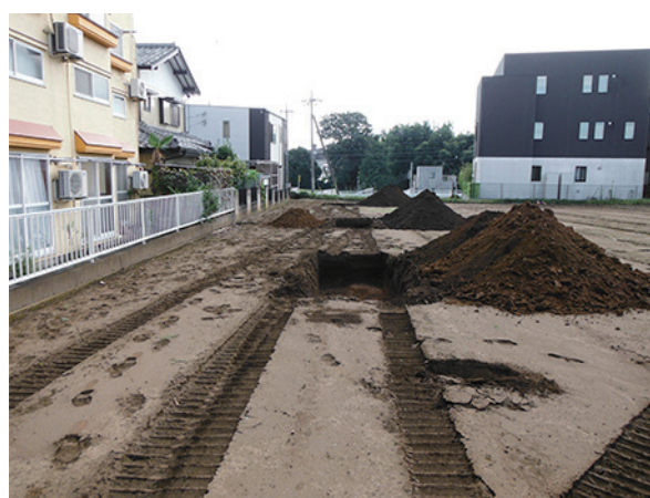
トレンチ写真2
