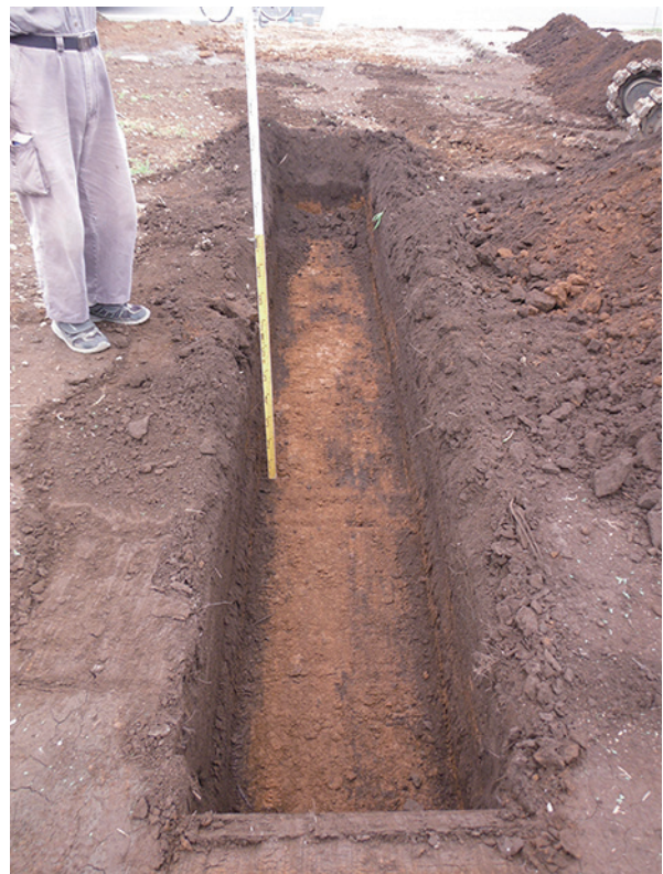
トレンチ写真
