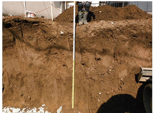
トレンチ写真2
