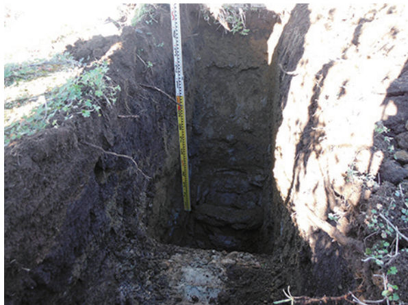
トレンチ写真1
