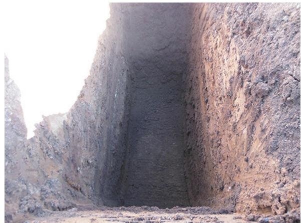
トレンチ写真2
