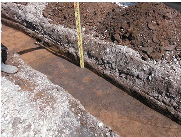
トレンチ写真1
