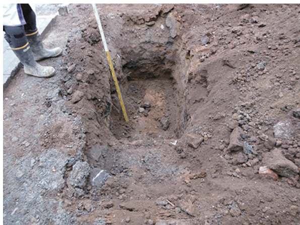
トレンチ写真
