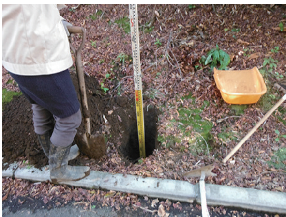
トレンチ写真1
