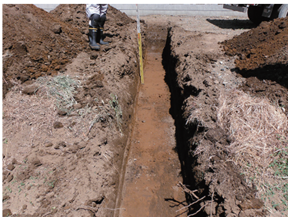
トレンチ写真1
