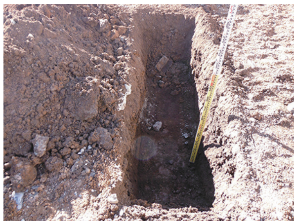
トレンチ写真1
