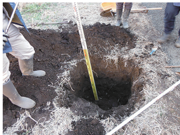
トレンチ写真2
