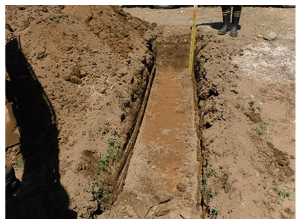
トレンチ写真2
