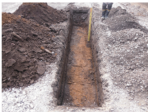
トレンチ写真1
