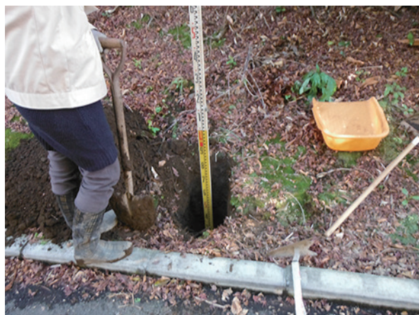
トレンチ写真1
