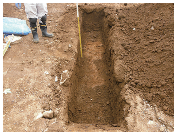
トレンチ写真
