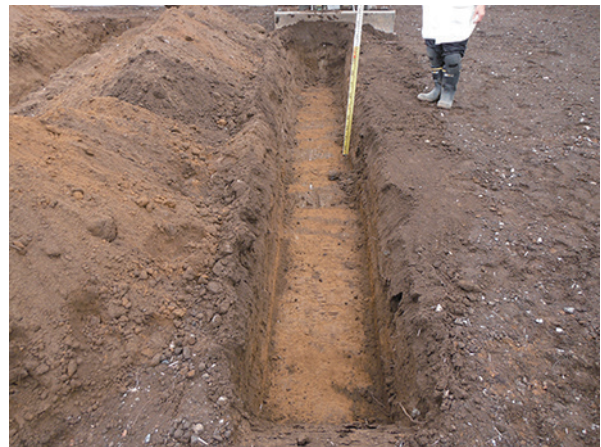
トレンチ写真
