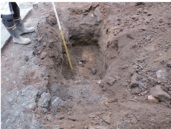
トレンチ写真
