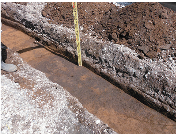
トレンチ写真1
