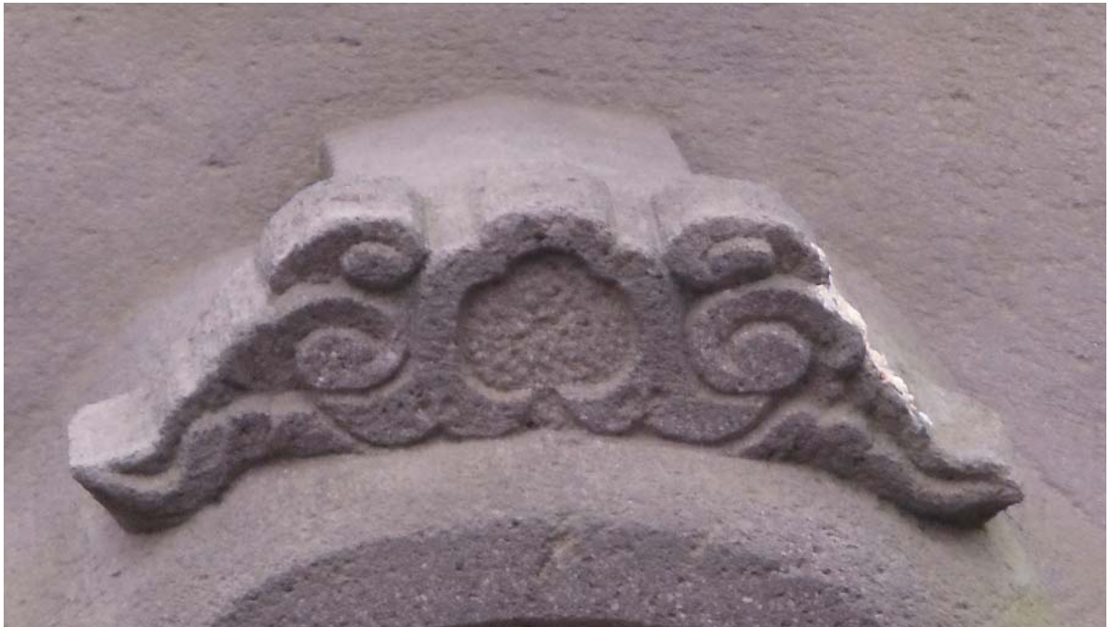
図 14-2 正面屋根部分
