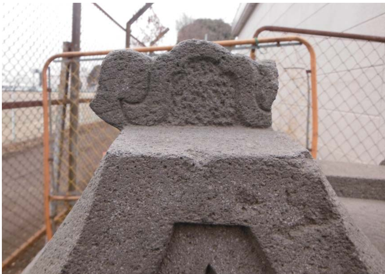
図 18-2 左側面屋根上
