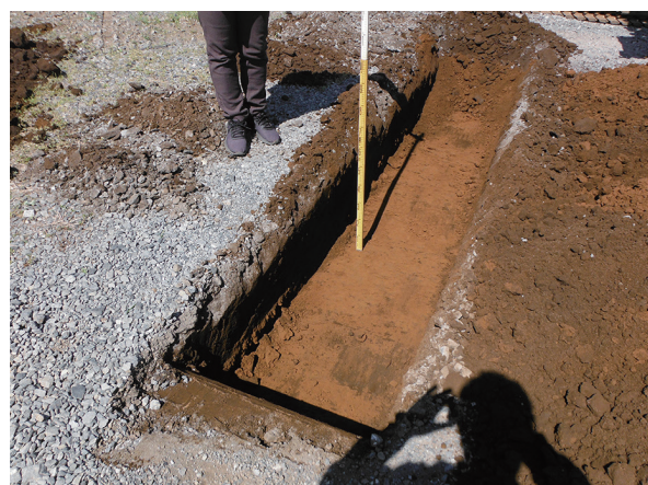
トレンチ写真 2
