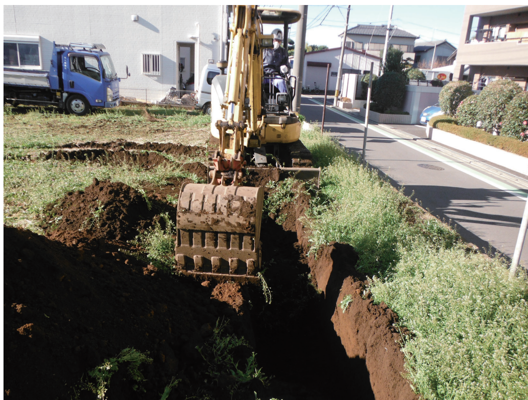
第7図 1 トレンチ掘削状況
