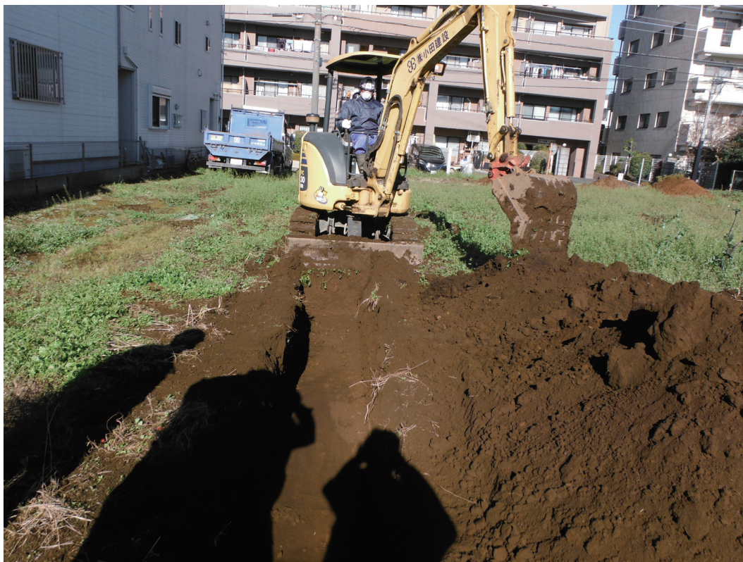
第8図 6トレンチ掘削状況
