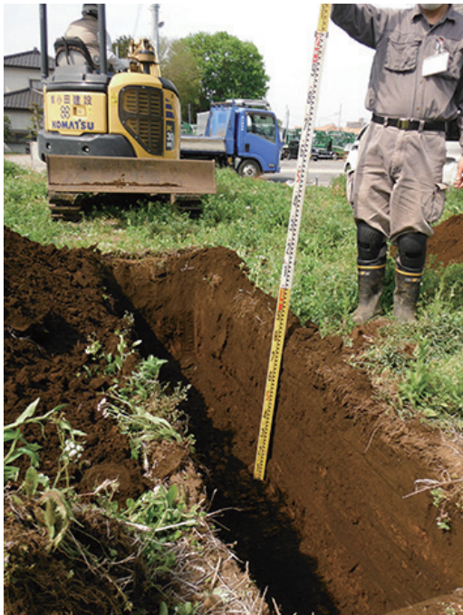
トレンチ写真1
