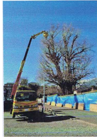
高所作業車による剪定作業
