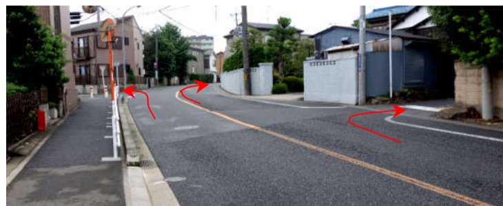
道路部（左奥：合之道 中：新設道路 右：引又道） （右手前：柳下家）
