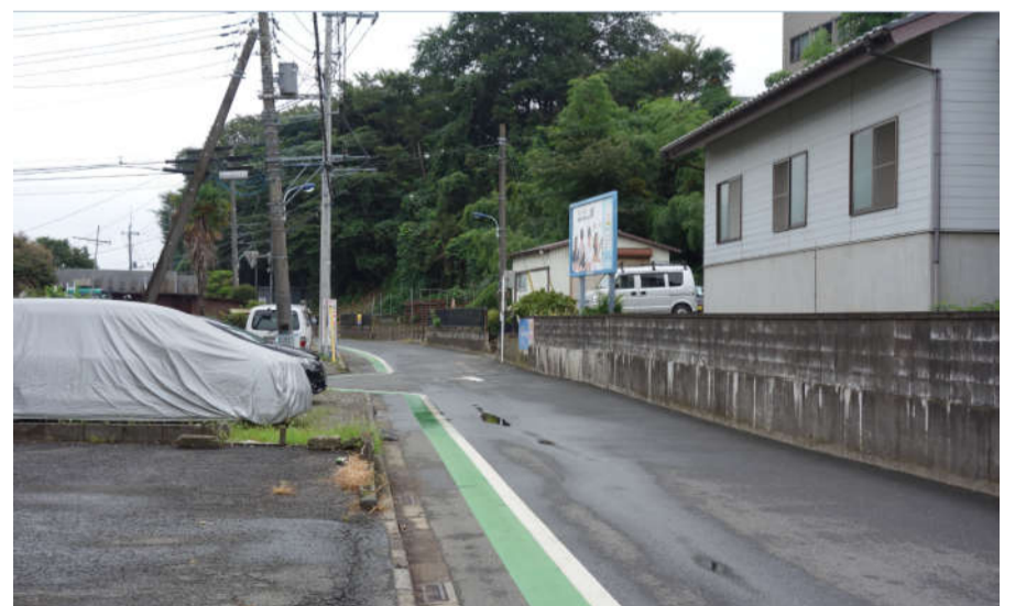
午王山北側のハケタミチ 前方は午王山 左側一体、昔はすべて見通しがきいた水田であった。 右側の建屋の奥・道路に面した場所が⑦'の位置となる。
