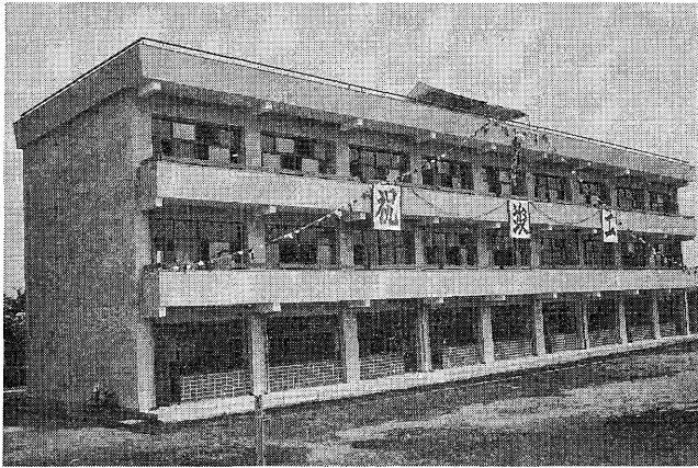
写真 6-26 大和中鉄筋校舎（昭和36年8月）
