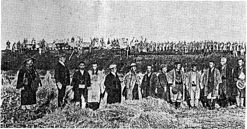
写真5-48 下新倉堤防工事記念
