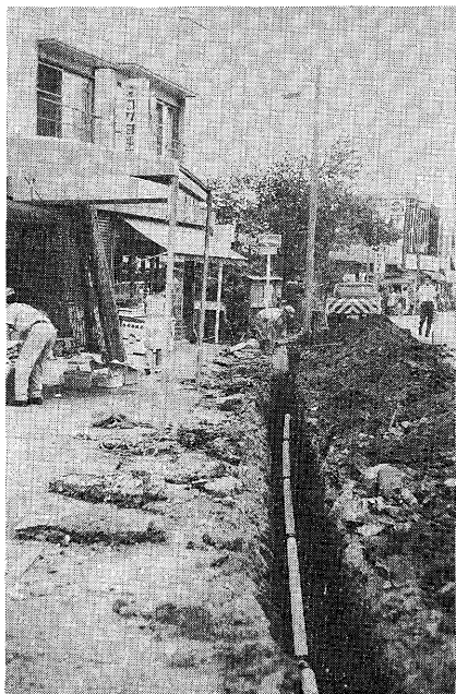
写真 6-16 水道管敷設工事
