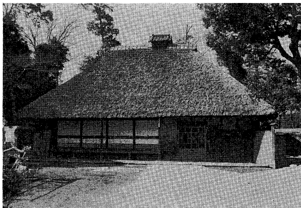
煙出しのついた寄棟屋根・瓦棟（三協）
